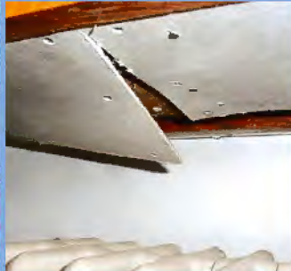
Asbesthaltige Leichtbauplatten
