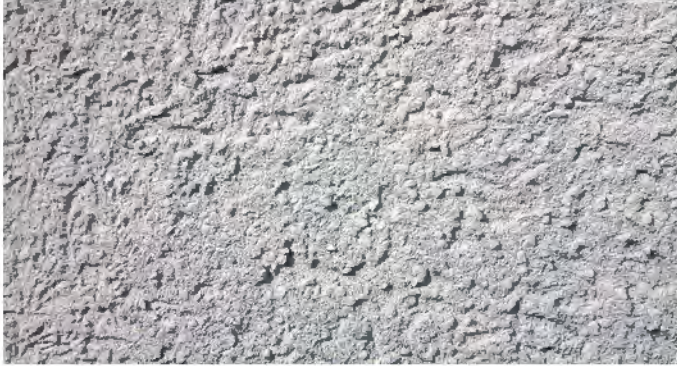
Asbesthaltiger Akustikputz/Abrieb
