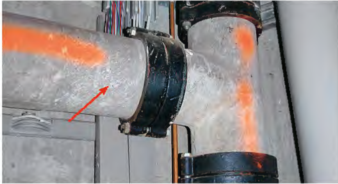
Asbestzementrohr
