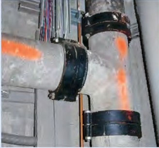
Asbestzement-Rohre
