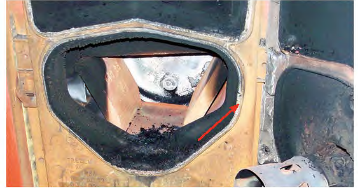
Asbestschnur als Dichtung
