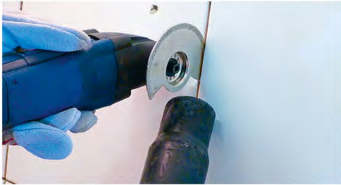
Austausch defekter Platten
