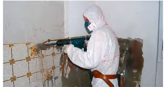
Platten nass entfernen/abschlagen (<5 m 2 )
