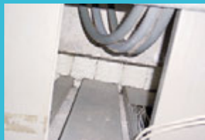
Zwie Beispiele von Brandabschottungen mit Asbestkissen
