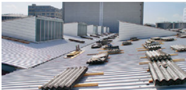
Asbesthaltige Wellplatten
