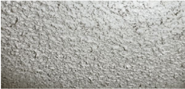
Asbesthaltiger Akustikputz
