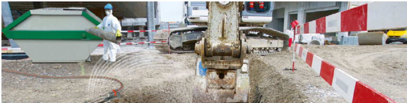
Rückbau asbesthaltiger Rohrleitungen
