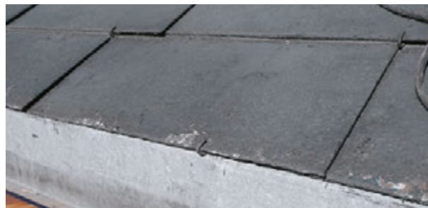
Asbesthaltige Schieferplatten
