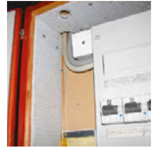
Asbesthaltige Leichtbauplatten als Brandschutz
