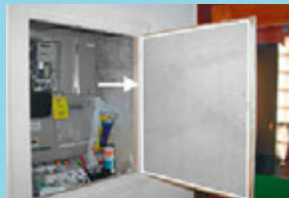
Asbesthaltige Brandschutzplatte
