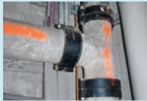
Asbestzementrohre
