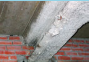
Spritzasbestisolierung
