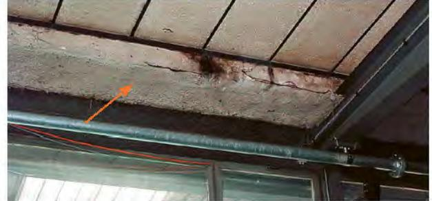
Spritzasbestisolation an Dachkonstruktion
