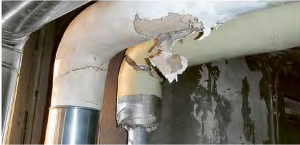
Rohrleitung mit asbesthaltigem Mörtel
