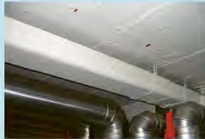
Kabelkanal aus Asbestzement
