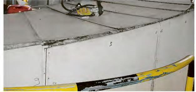
Asbesthaltige Dämmung hinter einer Verkleidung
