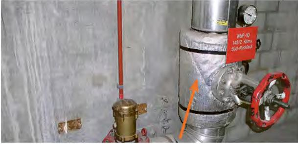
Isolationsschale für die Hitzeisolation
