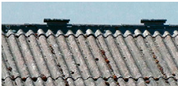
Asbestzementplatten
