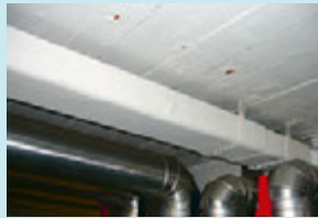
Kabelkanal aus Asbestzement
