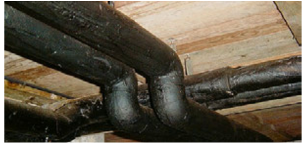
Asbesthaltiger Bitumenanstrich
