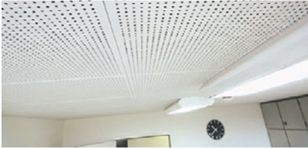
Deckenplatten bei abgehängten Decken
