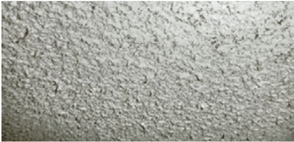
Asbesthaltiger Akustikputz
