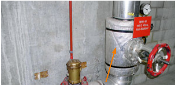
Isolationsschale für die Hitzeisolation
