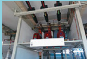
Brandschutzplatten als Trennwand
