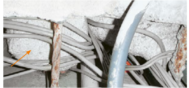
Asbesthaltige Brandschutzkissen
