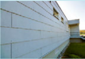
Asbesthaltige Fassadenplatten
