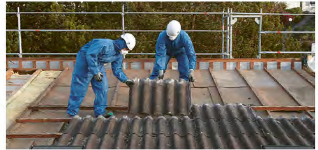
Rückbau von Wellplatten
