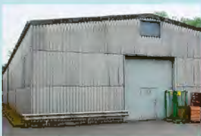
Asbesthaltige Wellplatten
