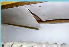
Asbesthaltige Leichtbauplatte
