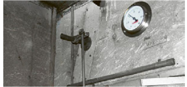
Lüftungskanal aus Asbestzementplatten
