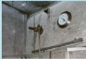
Lüftungsanlage aus Asbestzement
