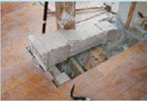
Lüftungskanal aus Asbestzement
