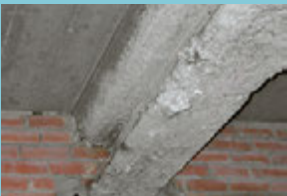
Spritzasbestisolierung
