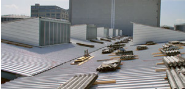
Asbesthaltige Wellplatten
