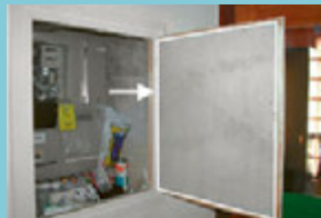
Asbesthaltige Brandschutzplatte
