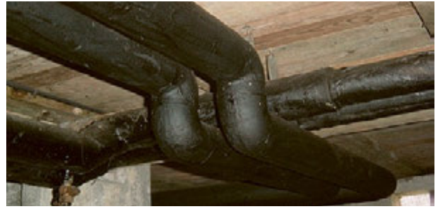
Asbesthaltiger Bitumenanstrich
