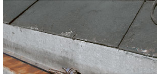
Asbesthaltige Schieferplatten
