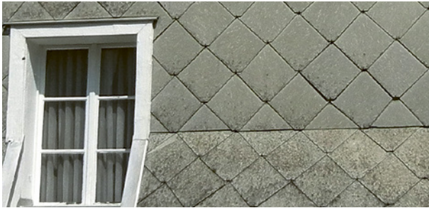
Asbesthaltige Fassadenplatten
