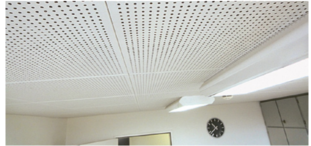
Deckenplatten bei abgehängten Decken
