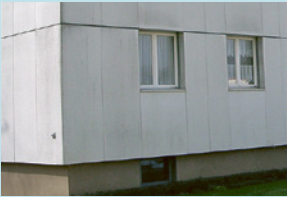
Asbesthaltige Fassadenplatten
