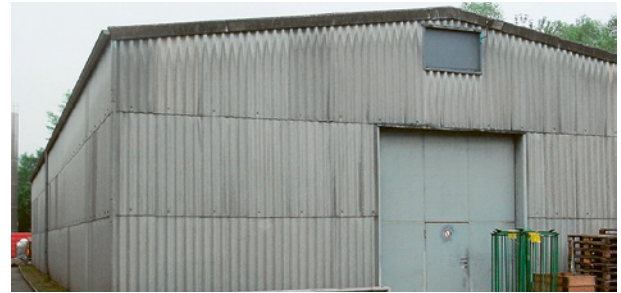
Asbesthaltige Wellplatten
