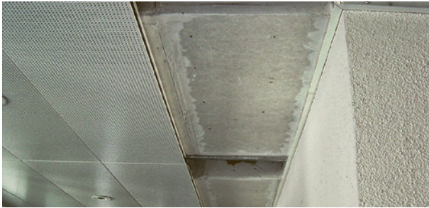
Asbesthaltige Deckenplatten
