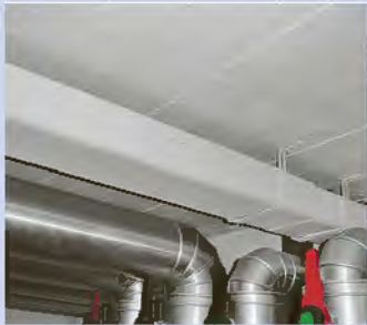
Kabelkanal aus Asbestzement
