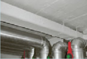
Kabelkanal aus Asbestzement
