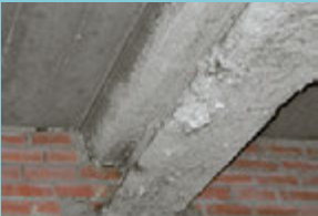
Spritzasbestisolierung
