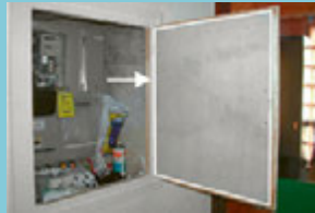
Asbesthaltige Brandschutzplatte
