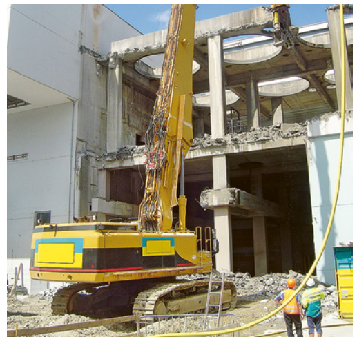
2 Bei maschinellem Rückbau dürfen sich keine Personen im Abbruchobjekt aufhalten.
