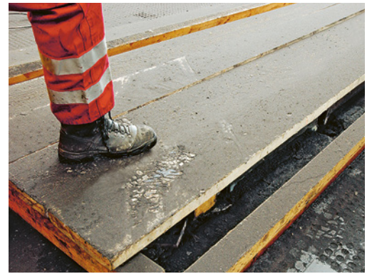
4 Vorsicht bei Abdeckungen, Gitterrosten, Blindböden usw.. Es besteht Durchbruchgefahr.
