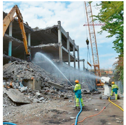
5 Die Staubentwicklung mit geeigneten Massnahmen eindämmen, z. B. durch Bedüsung am Abbaugerät, Benetzen mit Wasser.
