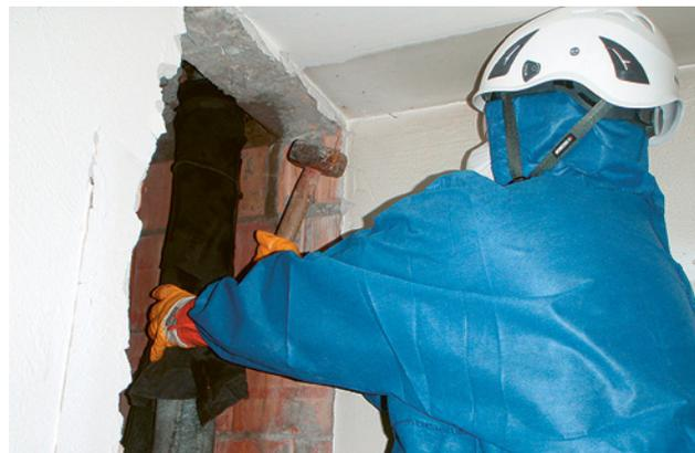
1 Ein Asbestzementrohr wird mit einem kontrollierten Hammerschlag gebrochen.
