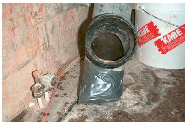
4 Abgeklebte Bruchkante, vorbereitet für die Entsorgung.
