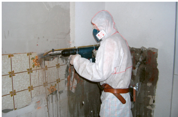
1 Platten mit asbesthaltigem Kleber werden mit einem Spitzhammer mit Wasserbedüsung entfernt.
