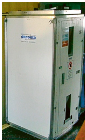
2 Eingang zur Sanierungszone (Schleuse, abgedichtet)
