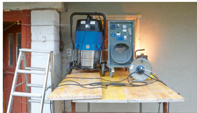
3 Unterdruckhaltegerät in einem Fenster eingebaut und abgedichtet. Der Schlauch des Staubsaugers wird durch die Abdichtung geführt.
