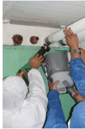
4 Schneiden eines Rohres mit der Fuchsschwanzsäge
