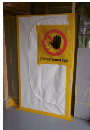
3 Dieser Arbeitsbereich ist räumlich sauber abgetrennt und gekennzeichnet.
