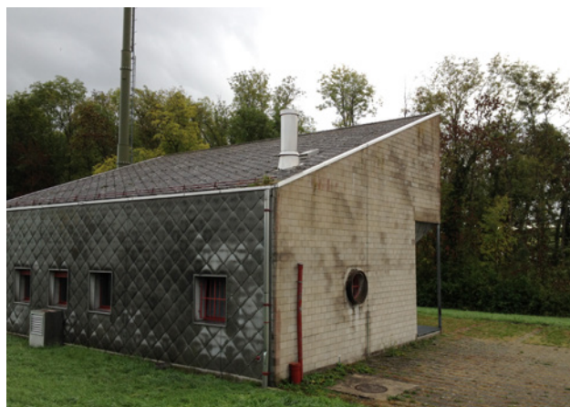
1 Neuer Schornstein auf einem Dach aus asbesthaltigem Faserzement
