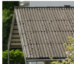
1 Asbestzement: Dachplatten
