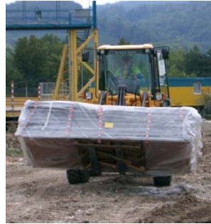
3 Festgebundener Asbest in Säcken oder mit Kunststoffolie staubdicht verpackt
