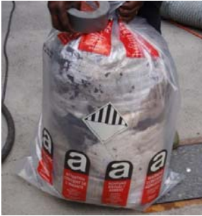
3 Festgebundener Asbest in Säcken oder mit Kunststoffolie staubdicht verpackt
