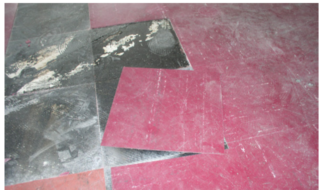
1 Bei einschichtigen Floor-Flex-Belägen (hart und brüchig) ist der Asbest im Kunststoff festgebunden.
