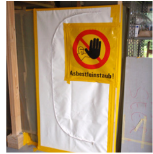
4 Dieser Sanierungsbereich ist sauber räumlich abgetrennt und gekennzeichnet.
