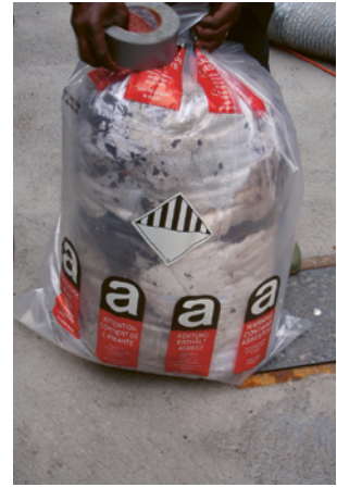
6 Kunststoffsack mit der Kennzeichnung Asbest
