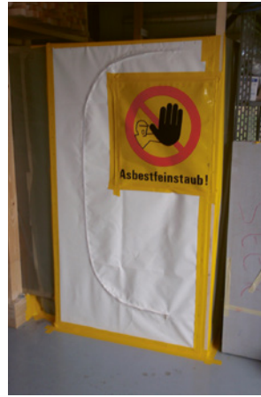
5 Sauber abgetrennter Arbeitsbereich
