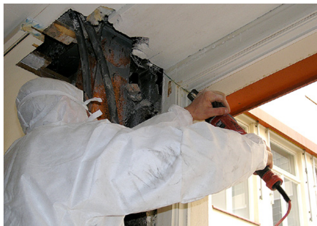
1 Aufschneiden des Fensterrahmens mit einer Fuchsschwanzsäge
