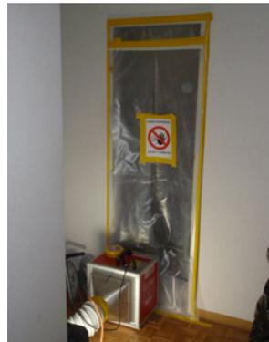
5 Abgetrennte Sanierungszone mit Unterdruckgerät
