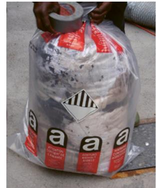
6 Kunststoffsack mit der Kennzeichnung Asbest
