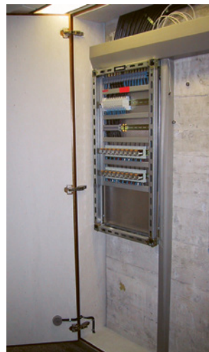
1 Asbesthaltige Leichtbauplatten, z. B. als Brandschutzverkleidungen im Inneren von Elektroanlagen, hier Türverkleidung
