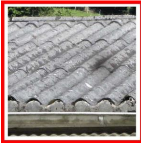
Faserzement Wellplatten auf Dächern / Fassaden
