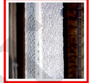
Spritzasbest Brandschutz auf Stahlträger, Decken
