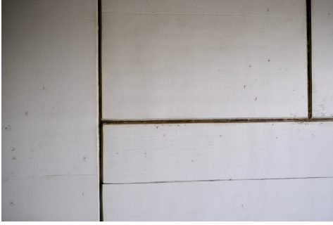
Fugendichtungsmasse, Gebäuediagnostik Siegart
