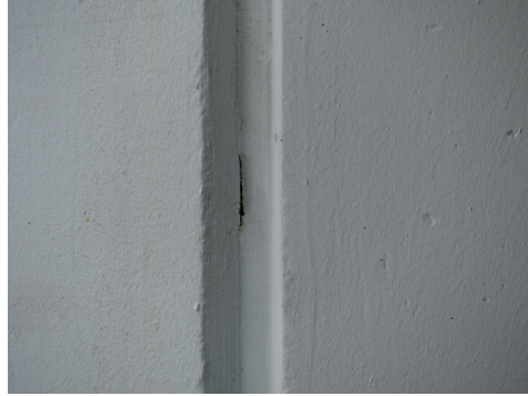
Fugendichtungsmasse, Gebäuediagnostik Siegart
